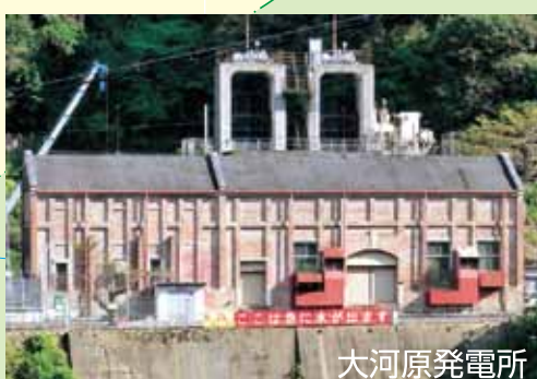
大河原発電所
